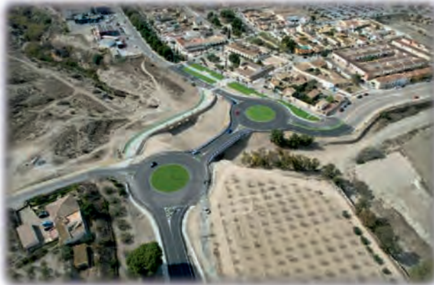
IMAGEN AÉREA DEL NUEVO PUENTE EN SAN ISIDRO, HUÉRCAL OVERA
